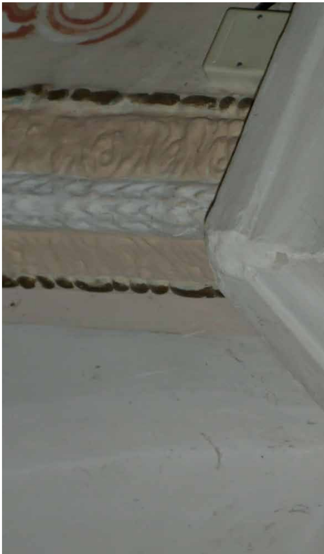
Deformácia modelácie štukovej výzdoby výsečí klenby lode kostola a časti modelácie hlavice pilastra
