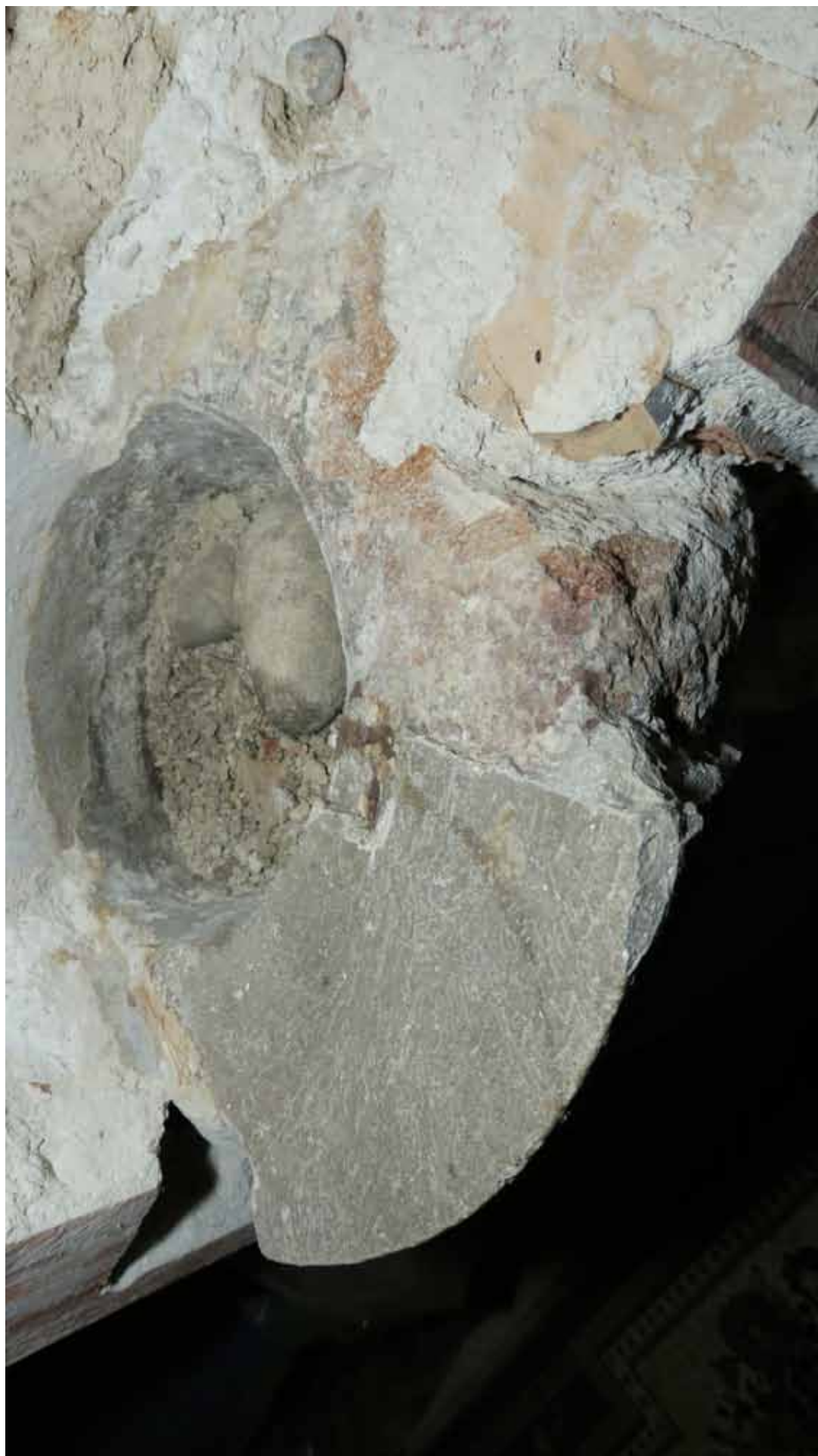
Svätenička v pilastri na južnej stene lode kostola - v sonde silne deštruovaná pôvodná kamenná hmota
