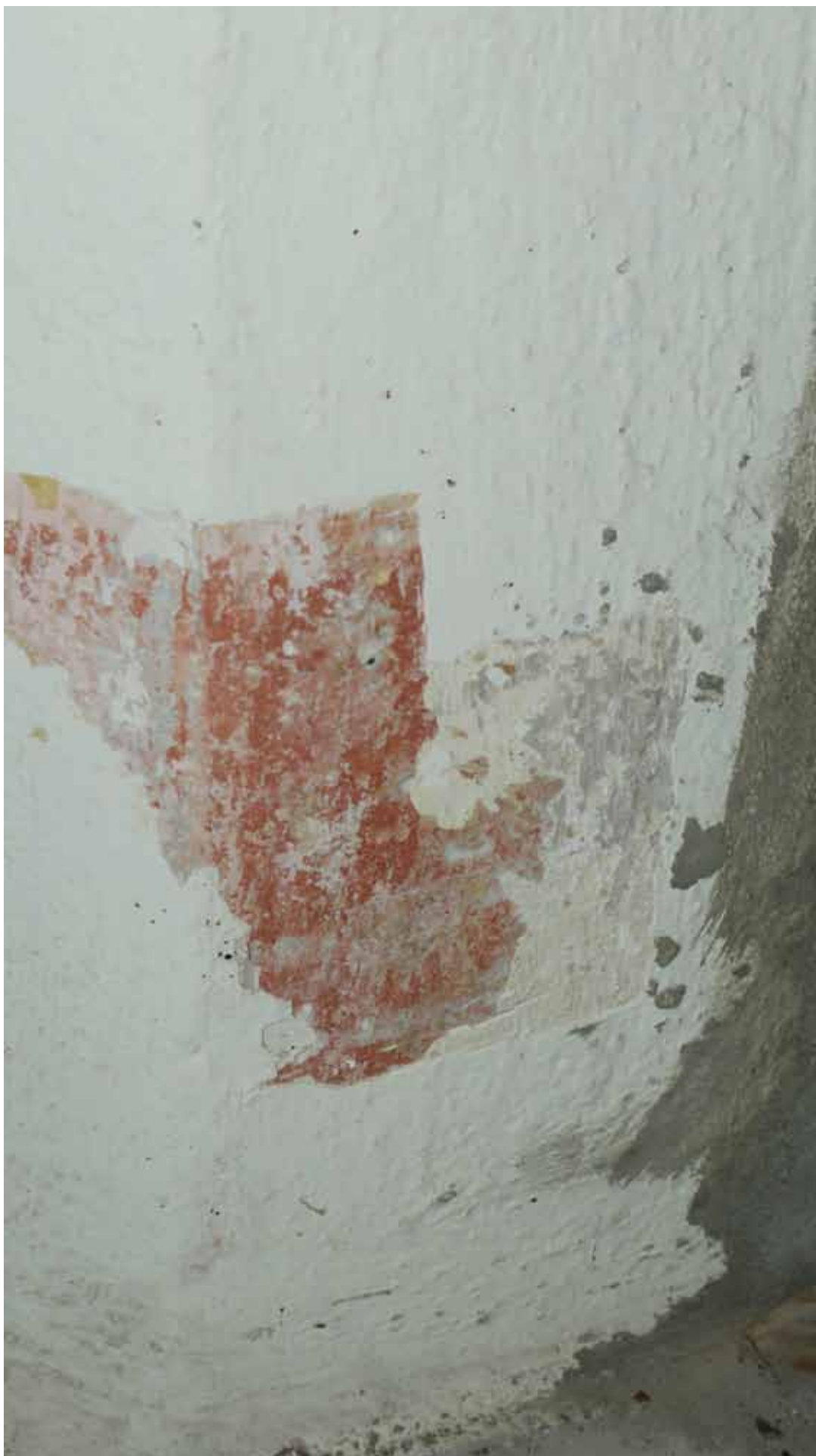
Južný vstup /exteriér/ - v sonde staršia farebná úprava z prvej polovice 20. storočia
