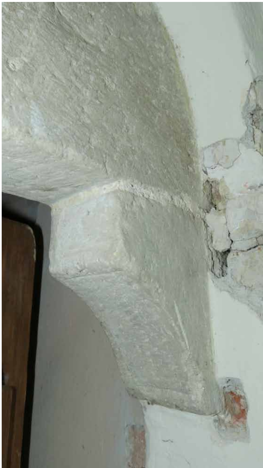
Východná časť nadpražia s konzolou - južný vstup /exteriér/
