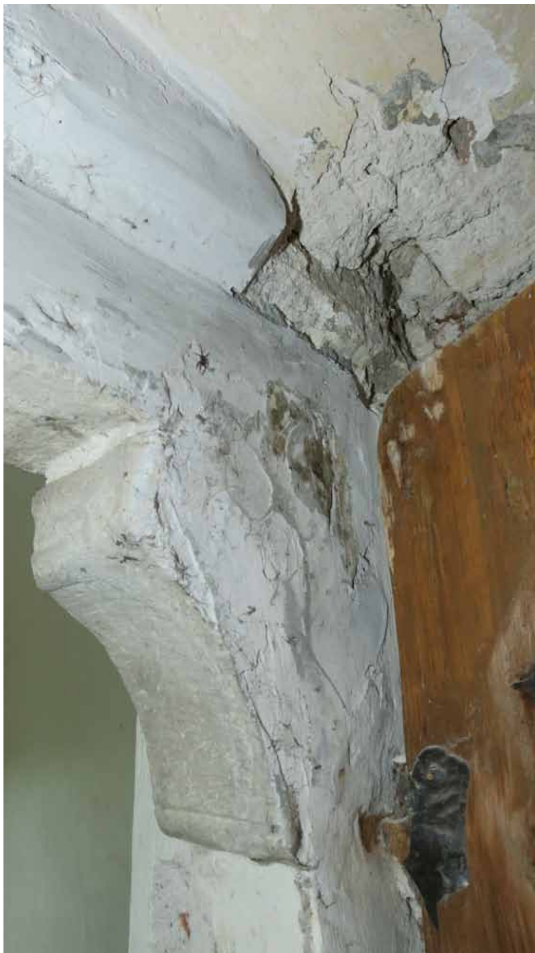
Západná časť nadpražia s konzolou - južný vstup /interiér/
