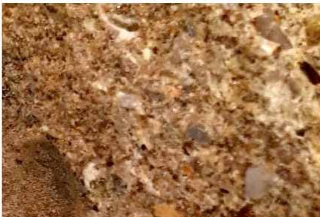
Foto č.4 Hrubozrnný kremenno - vápenatý pieskovec – vzorka č.4 – západný vstupný portál severná stojka. Na foto vidieť nerovnomerné granulometrické roztriebenie zŕn a rôznorodosť stmelení súčastí. V hrubozrnnom pieskovci sa nachádzajú aj drobné valúny vápencov a dolomitov. Obyčajné svetlo, zväčšenie 10x.
