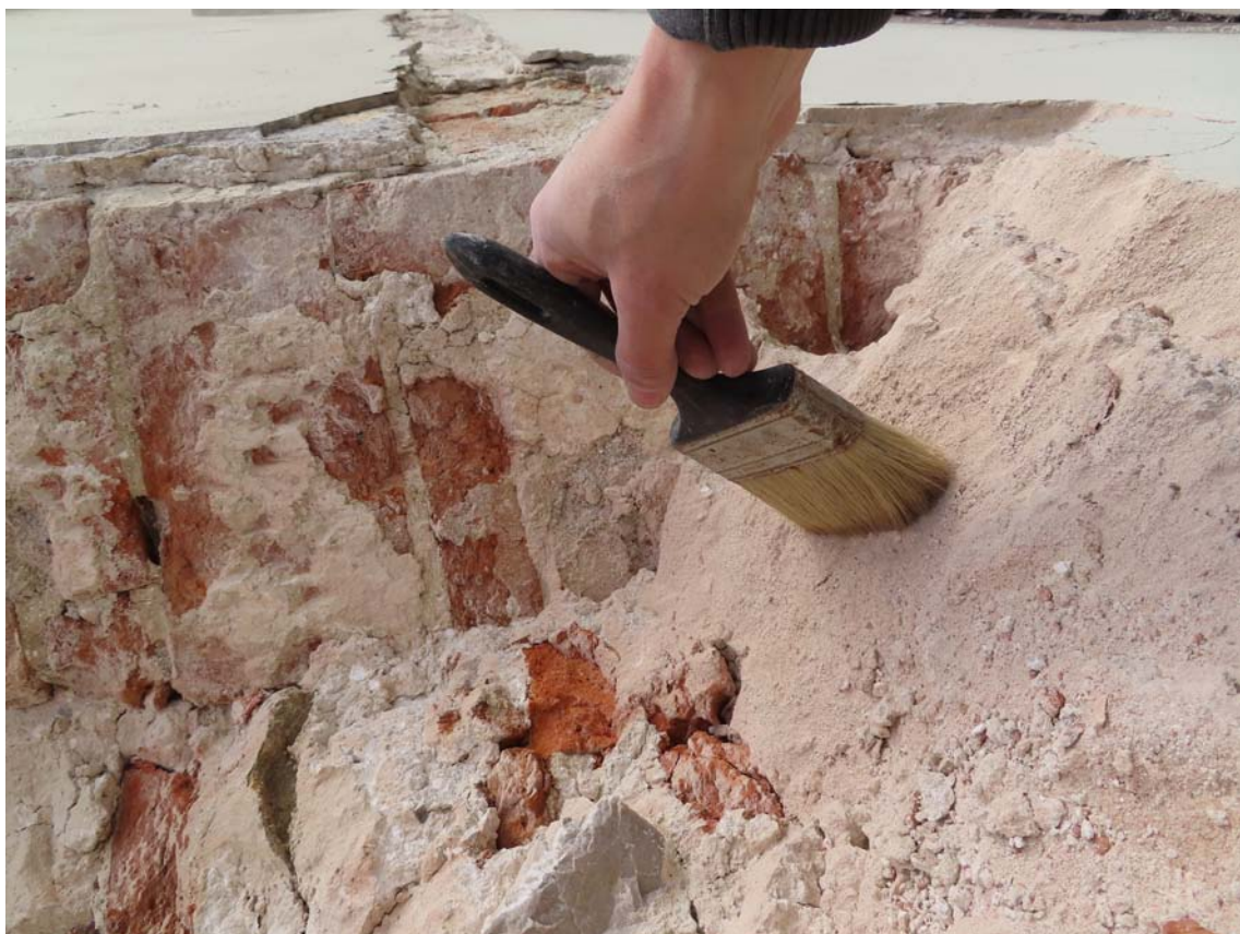
Dočisťovanie odkrytých historických omietkových vrstiev západného románskeho okna na južnej stene fasády po odstránení zámurovky
