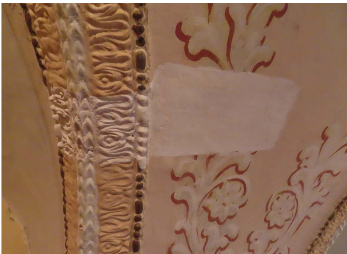
Úprava povrchu tmelov lazúrami na vápennej báze
