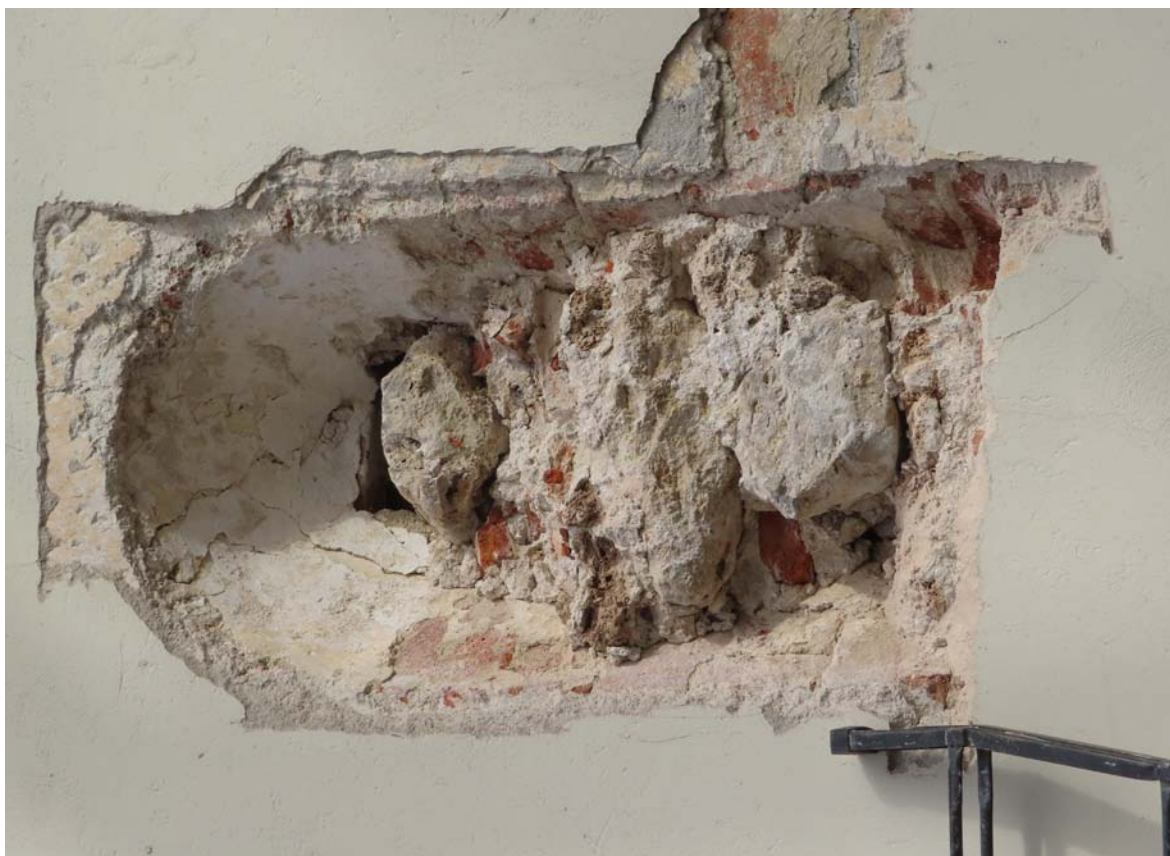
Postupné odstraňovanie sekundárnych vrstiev zámurovky západného románskeho okna na južnej stene fasády
