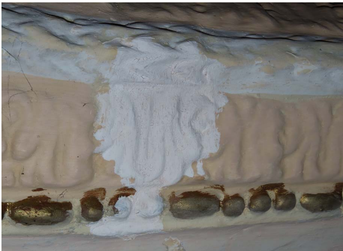
Úprava povrchu tmelov lazúrami na vápennej báze
