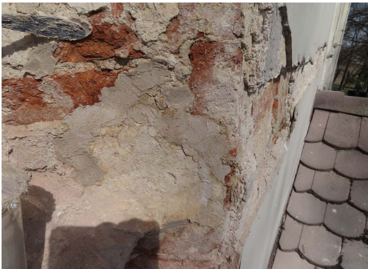
Upevňovanie omietkových vrstiev špalety západného románskeho okna na južnej stene fasády
