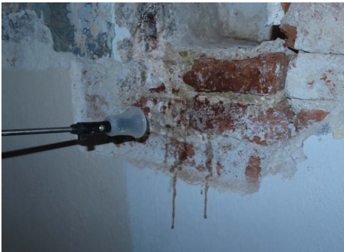
Lokálne spevňovanie odkrytých historických omietkových vrstiev rozprašovacím aplikátorom
