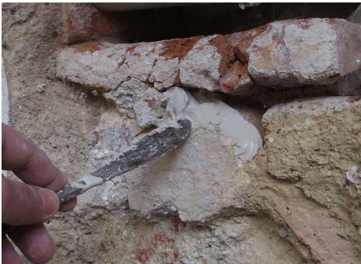
Odstraňovanie defektov omietkových vrstiev omietkou na báze haseného vápna
