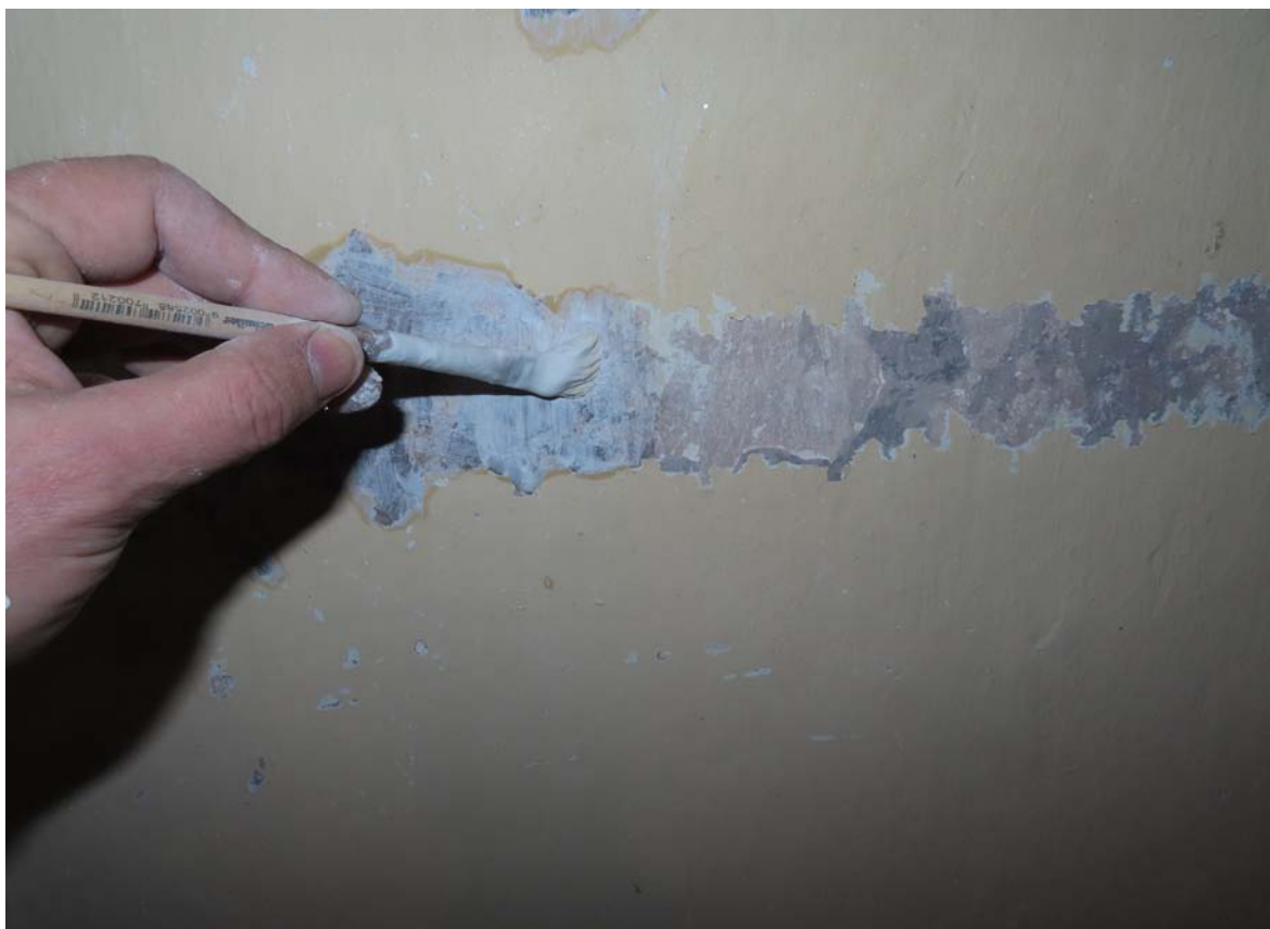
Úprava povrchu tmelov lazúrami na vápennej báze
