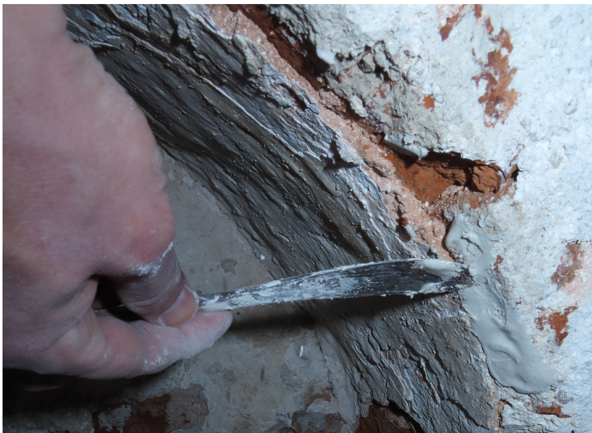
Upevnenie uvoľnených vrstiev západnej sedílie na južnej stene interiéru
