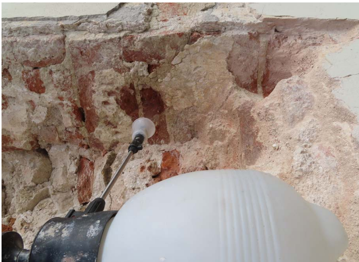
Lokálne spevňovanie odkrytých historických omietkových vrstiev západného románskeho okna na južnej stene fasády
