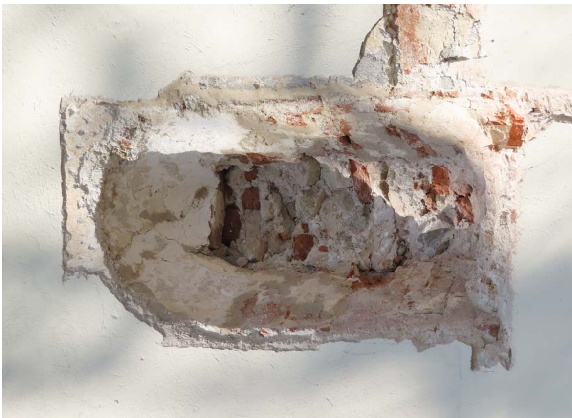
Západné románske okno na južnej stene fasády po ukončení prác
