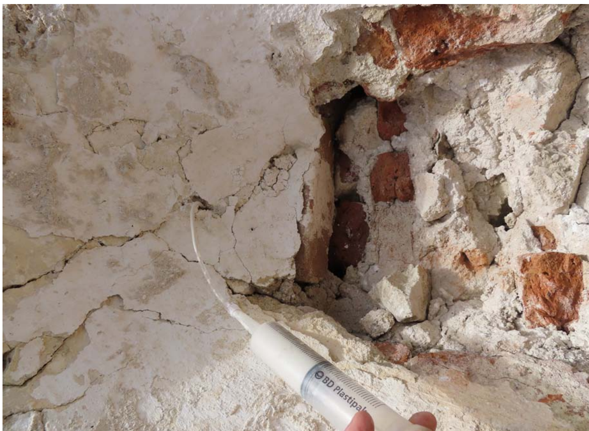
Injektáž historických omietkových vrstiev špalety západného románskeho okna na južnej stene fasády
