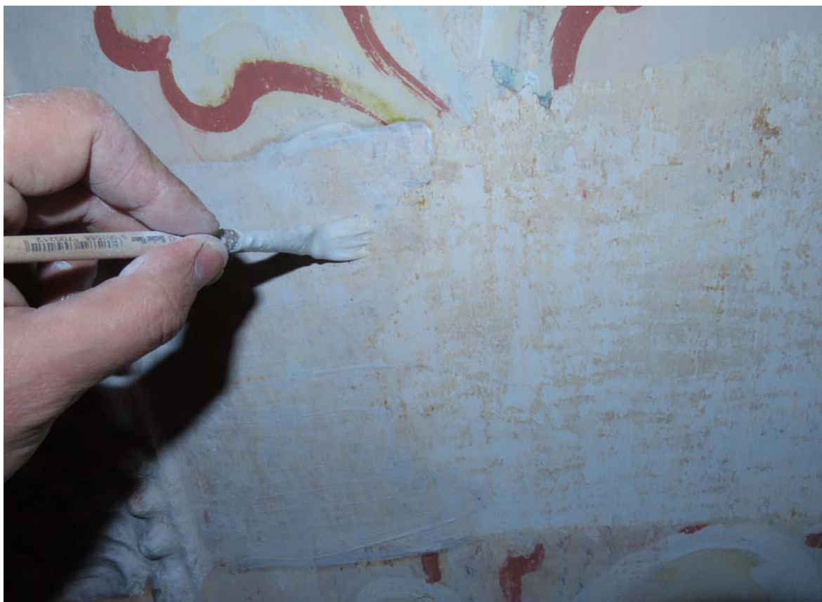
Úprava povrchu tmelov lazúrami na vápennej báze
