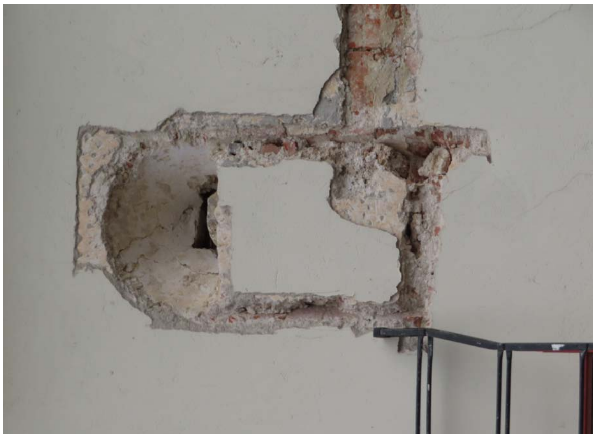
Západné románske okno na južnej stene fasády pre začatím prác
