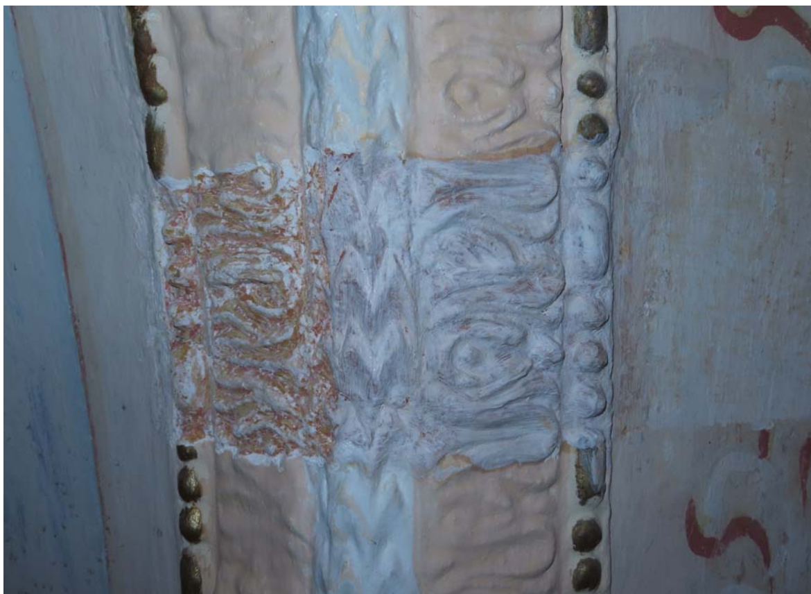
Úprava povrchu tmelov lazúrami na vápennej báze čiastočné prekrytie
