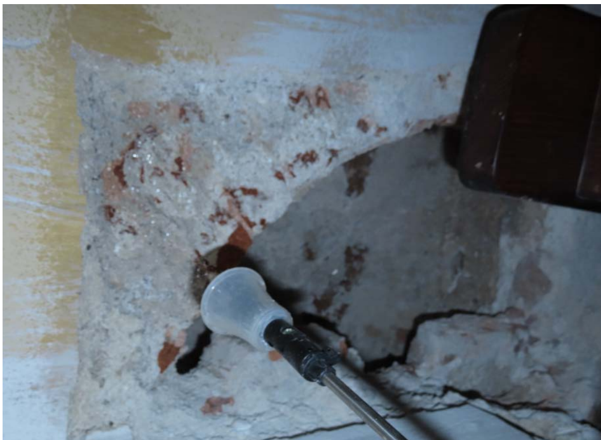
Lokálne spevnenie uvoľnených vrstiev západnej sedílie na južnej stene interiéru prípravkom na báze organokremičitanu
