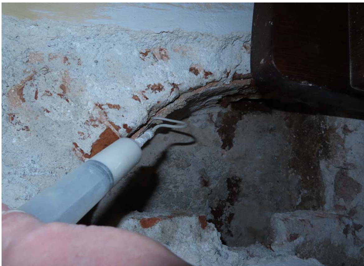
Injektáž uvoľnených vrstiev západnej sedílie na južnej stene interiéru
