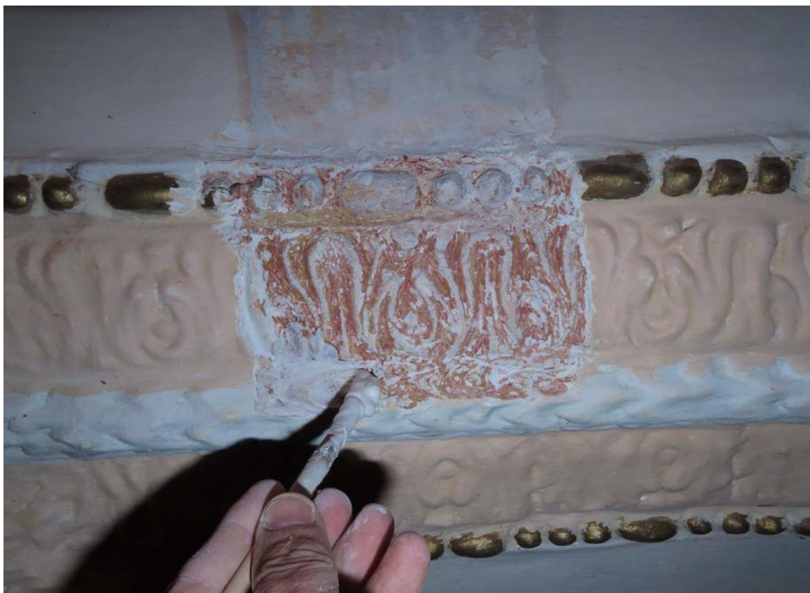
Úprava povrchu tmelov lazúrami na vápennej báze
