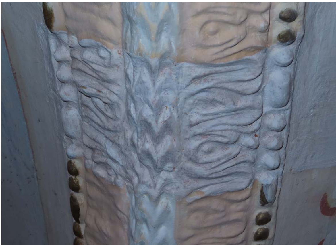
Úprava povrchu tmelov lazúrami na vápennej báze plné prekrytie
