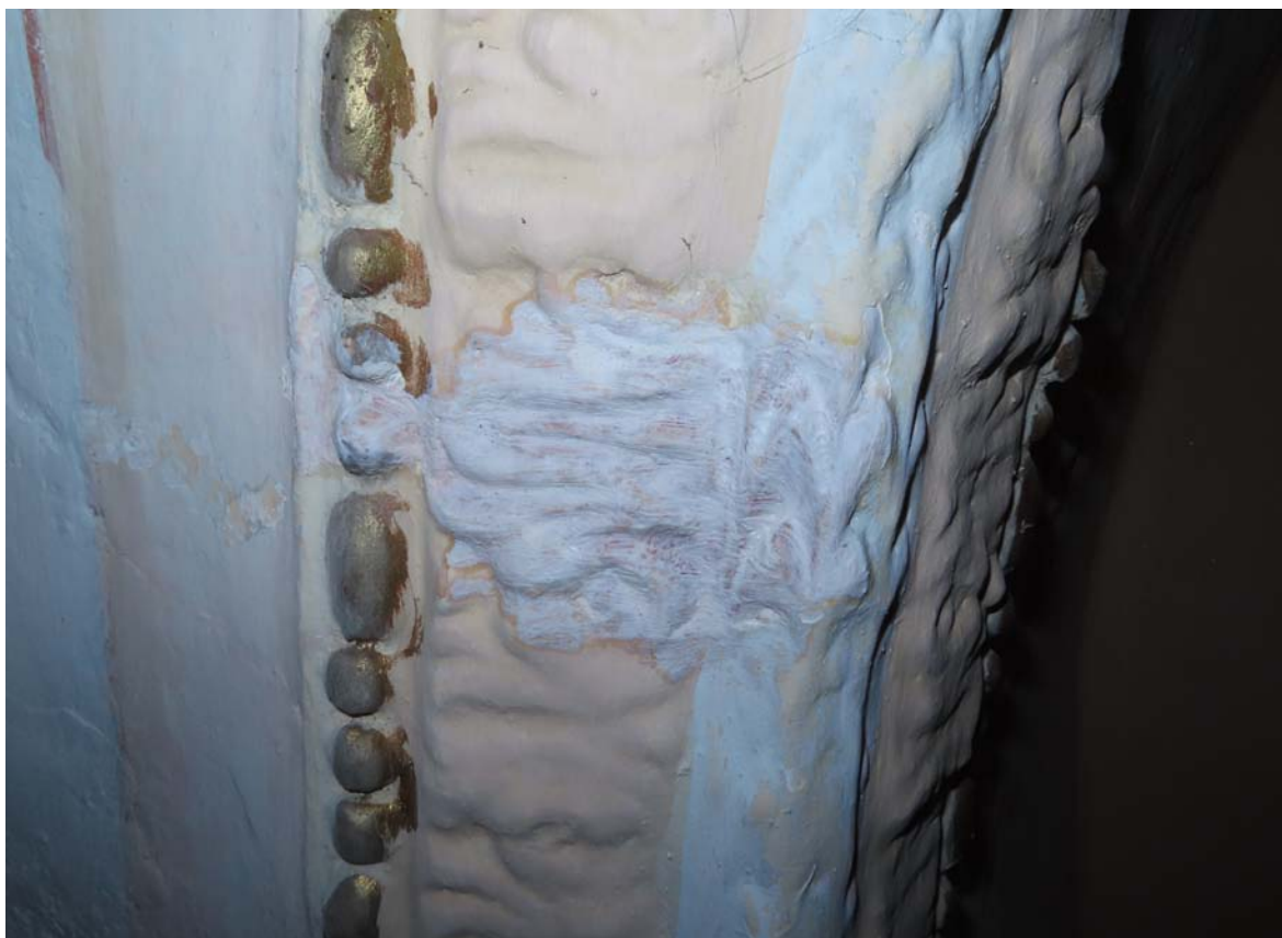
Úprava povrchu tmelov lazúrami na vápennej báze
