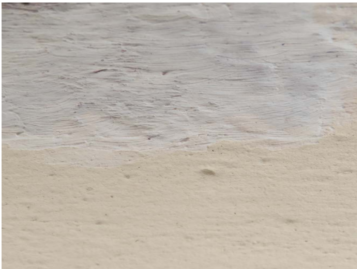
Úprava povrchu tmelov lazúrami na vápennej báze napodobenie štruktúry povrchovej úpravy
