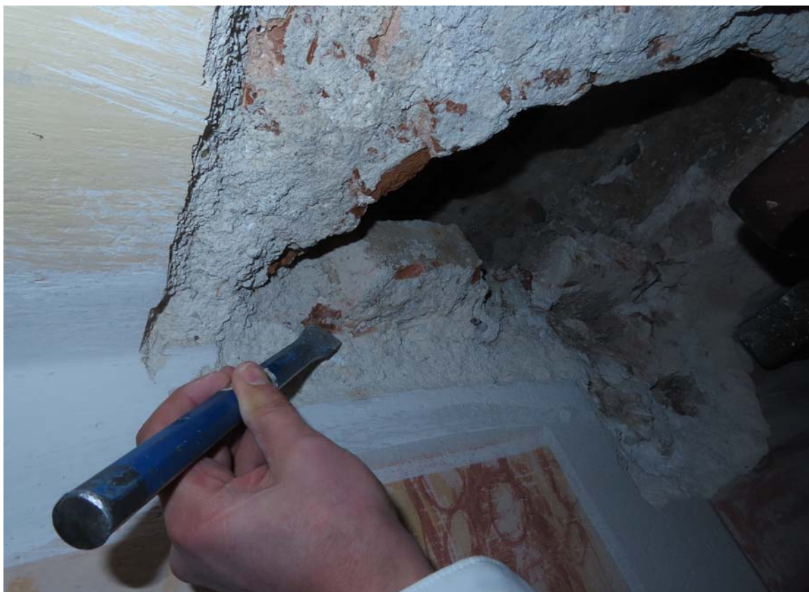
Odstraňovanie sekundárnych vrstiev a zámurovky západnej sedílie na južnej stene interiéru
