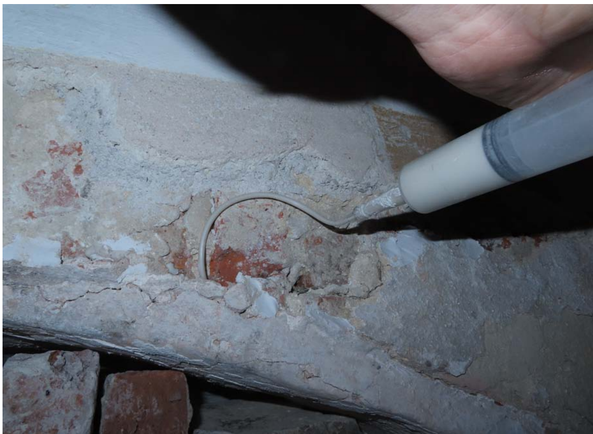
Injektáž odkrytých historických omietkových vrstiev injektážnou maltou PLM-AL
