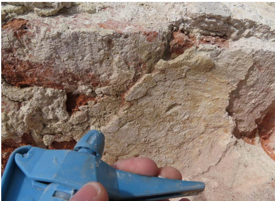
Úprava savosti podkladu pred injektážou uvoľnených vrstiev omietok a náterov
