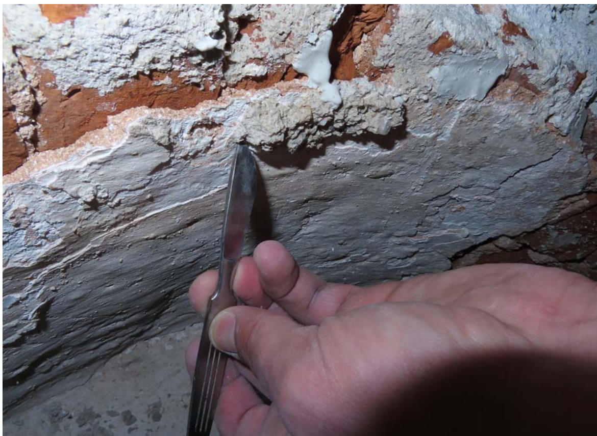
Odstraňovanie sekundárnych vrstiev a zámurovky západnej sedílie na južnej stene interiér
