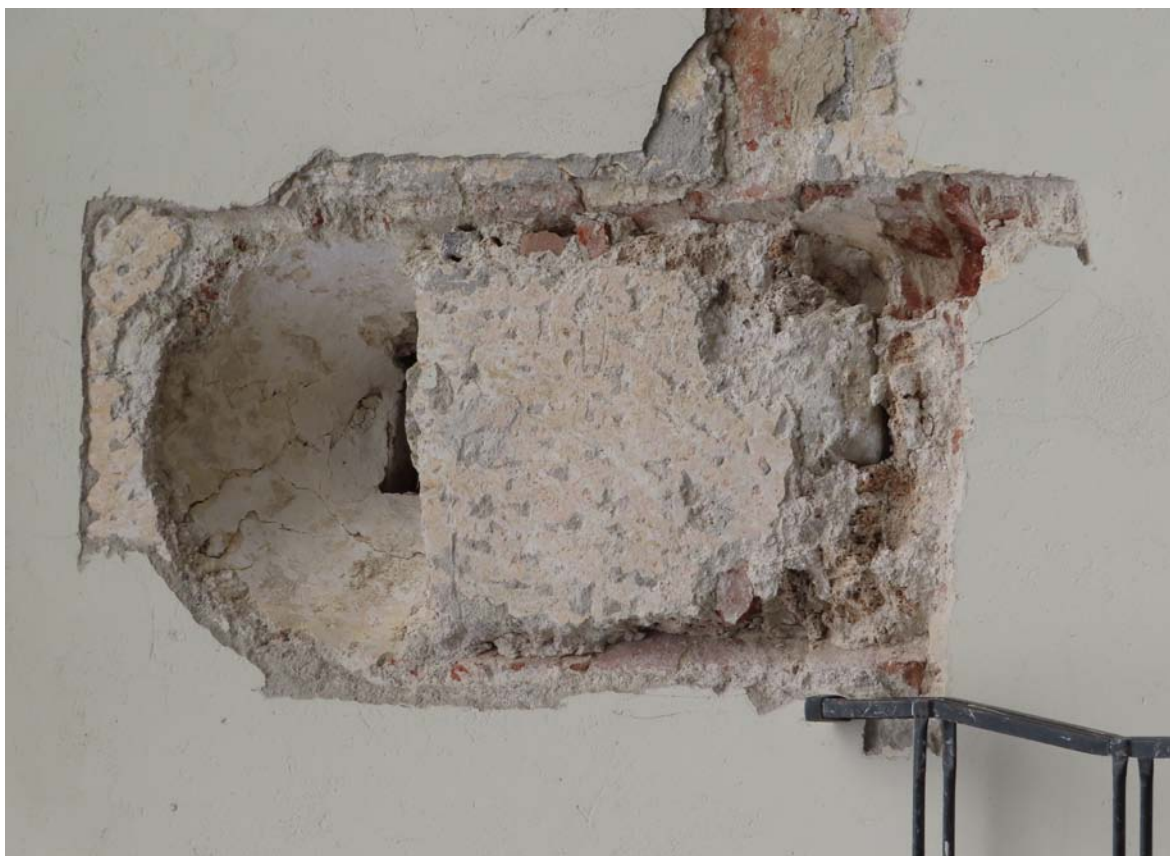
Postupné odstraňovanie sekundárnych vrstiev západného románskeho okna na južnej stene fasády
