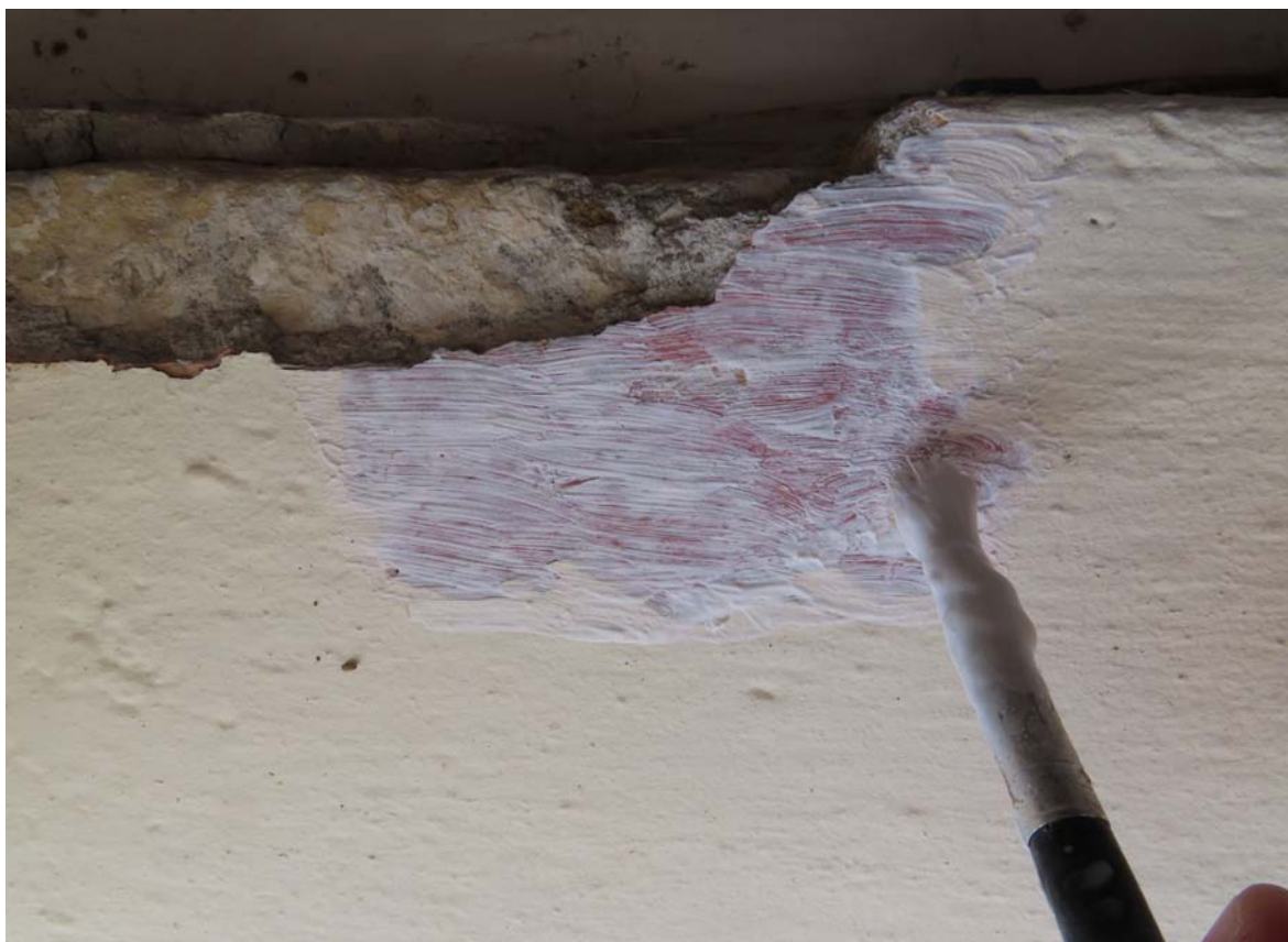
Úprava povrchu tmelov lazúrami na vápennej báze
